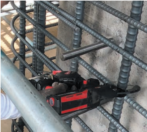
土木工事 橋梁 補強工事 D38×D22
