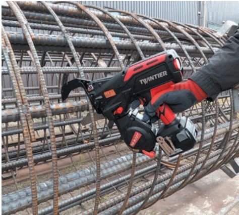
場所打ち杭 鉄筋かご 3層組 D32×D32×D13
